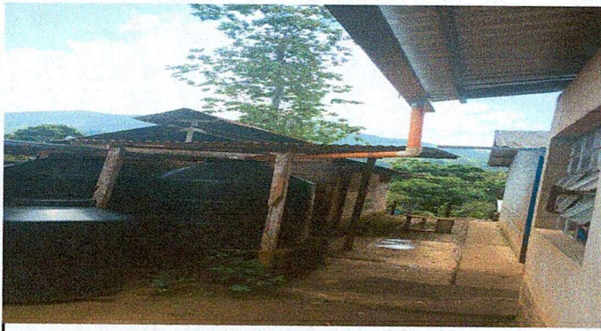
Foto 3: Cocina y area de deposito de agua de lluvia.
